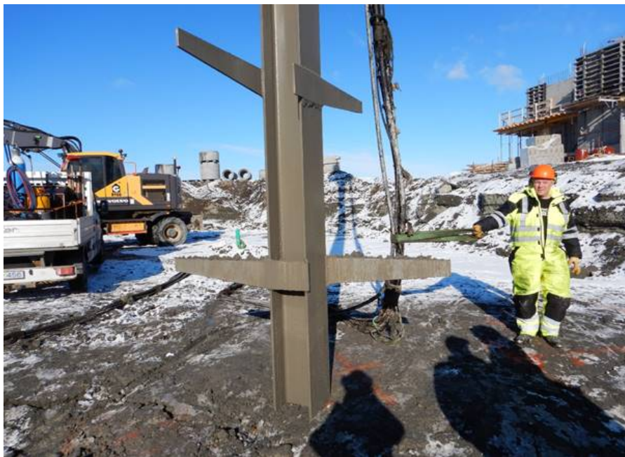
Mynd 11 Djúppjöppun með titurstaur. Hér eru tvenn „eyru“, soðin hornrétt á bitann. Hvert eyra er tæpur einn metri á lengd, um 0,25 m breið stálplata við staurinn.
