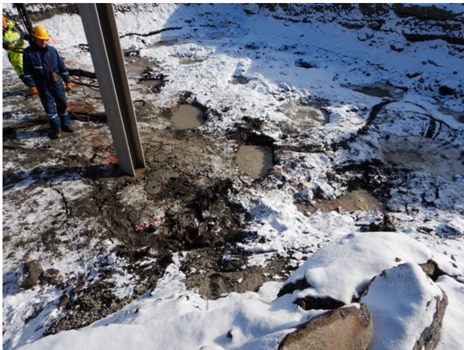
Mynd 12 Djúppjöppun með titurstaur. Nokkrar þjöppunarholur á svæðinu.
